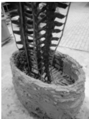
図 49-1 埋没材で土手を築いていく
