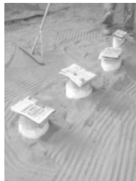
図 69-2 鑄造時の土間
