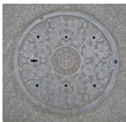
図21：マンホールの蓋 鋳鉄 筆者撮影
