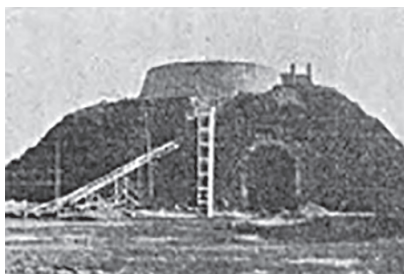
図5 造成中の道徳観音山
