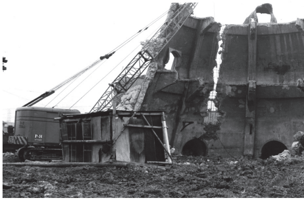
図9 解体中の道德観音山(1964年)
