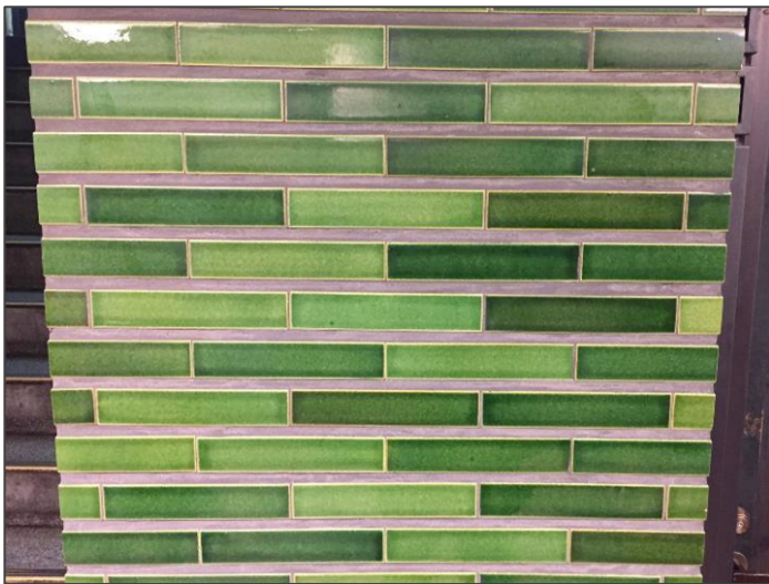
【図6】大日本麦酒本社ビル・ビヤホール(現・サッポロ・ライオン銀座7丁目店)・オフィス・フロアへの階段、廊下部分の陶製タイル 図5～6：筆者撮影
