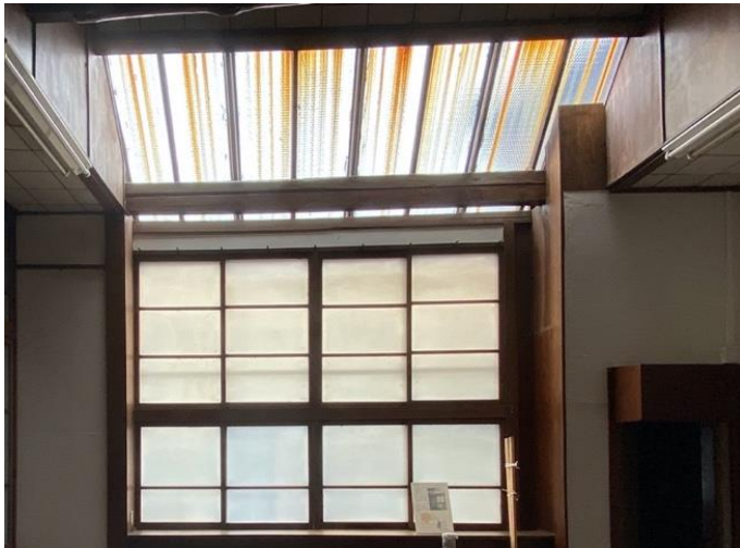
図 5-3 旧平櫛田中邸アトリエ内北側の窓
