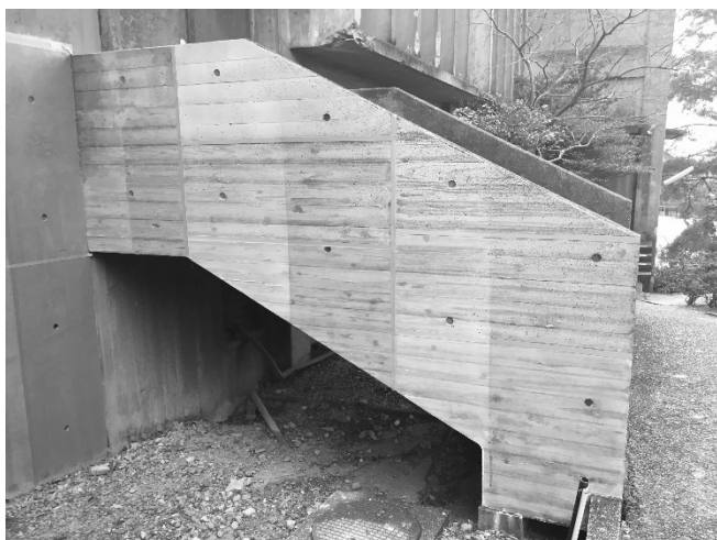
写真 3-3-19： コンクリート打放仕上のモルタル補修後の美観再現のモックアップ
