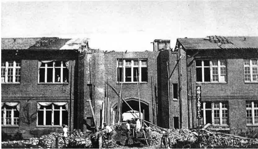
写真 3-1-14： 1925 年の再建では崩壊した 3 階および塔を一旦除去し、塔屋とその四周の塔を新設している。3 階床レベルを境に、下部は創建時の煉瓦躯体のまま、上部は鉄筋コンクリート躯体に煉瓦仕上としている。(資料 A)
