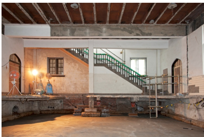
写真 3-1-22 : 基礎部分の掘削を完了 (資料 D)
