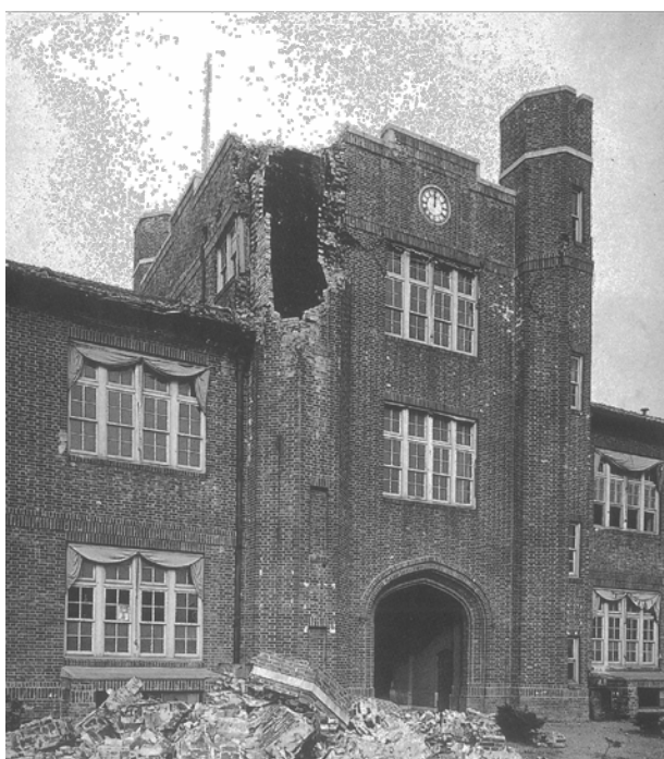
写真 3-1-04 : 関東大震災時の本館の被災状況（資料 A）
