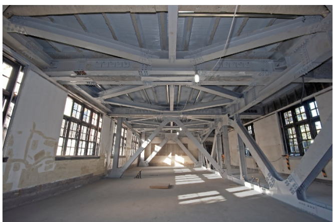
写真 3-1-24 : 鉄骨ブレースによる補強工事を完了 (資料 D)
