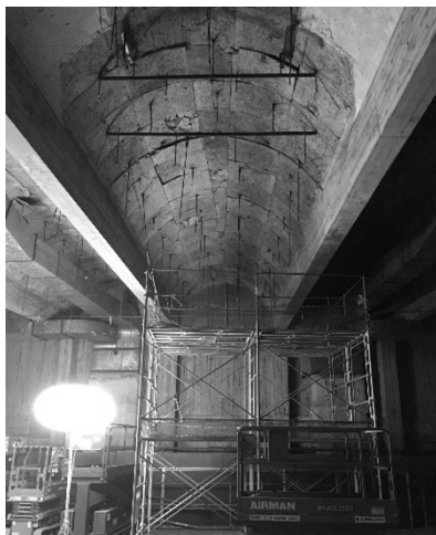
写真3-3-17： 既存天井解体時の状況（左）と、大梁に横架材を渡し新たな天井下地を構築した状態（右）。
