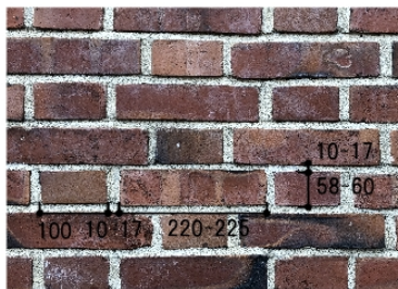
写真 3-2-16 : 第一食堂 外壁煉瓦の表情と寸法
