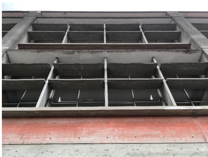
写真3-3-08： PC製の水平ルーバーの垂れ下がり・欠損
