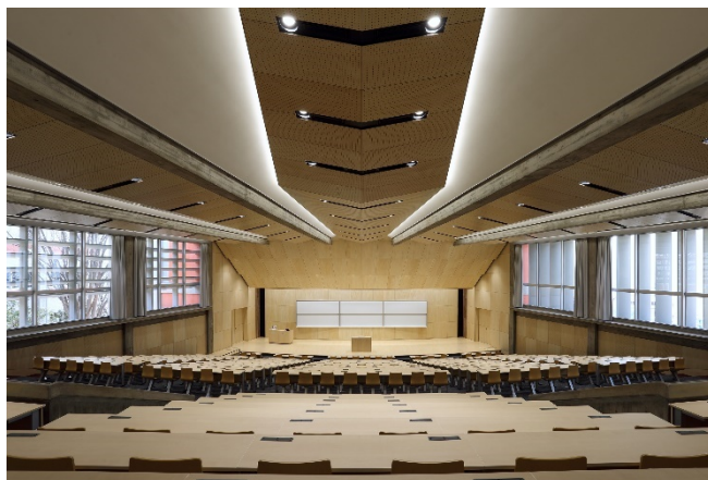
写真 3-3-20 : G30 教室南北面のサッシの更新 大判の複層ガラスとすることで透明感と断熱性を向上させている。
