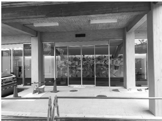
写真 3-3-18： コンクリート打放仕上のモルタル補修後の美観再現（柱部分）
