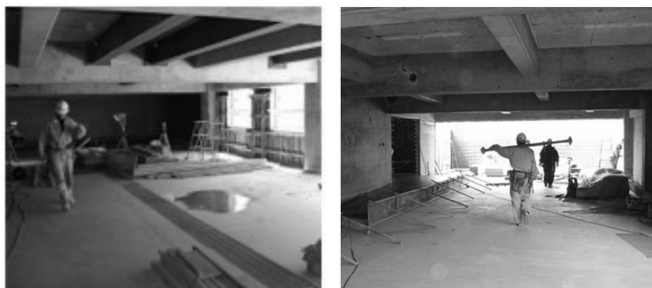
写真3-4-23： 南側事務室（梁下2.1m）・基礎梁未改修（左） 北側情報コーナー（梁下2.6m）・基礎梁改修部分（右）
