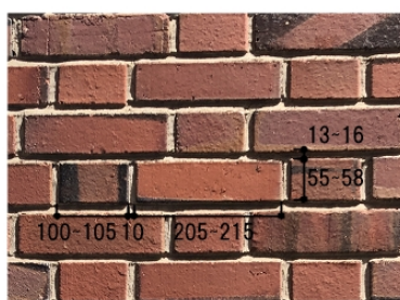
写真 3-2-18 : チャペル会館 外壁煉瓦の表情と寸法
