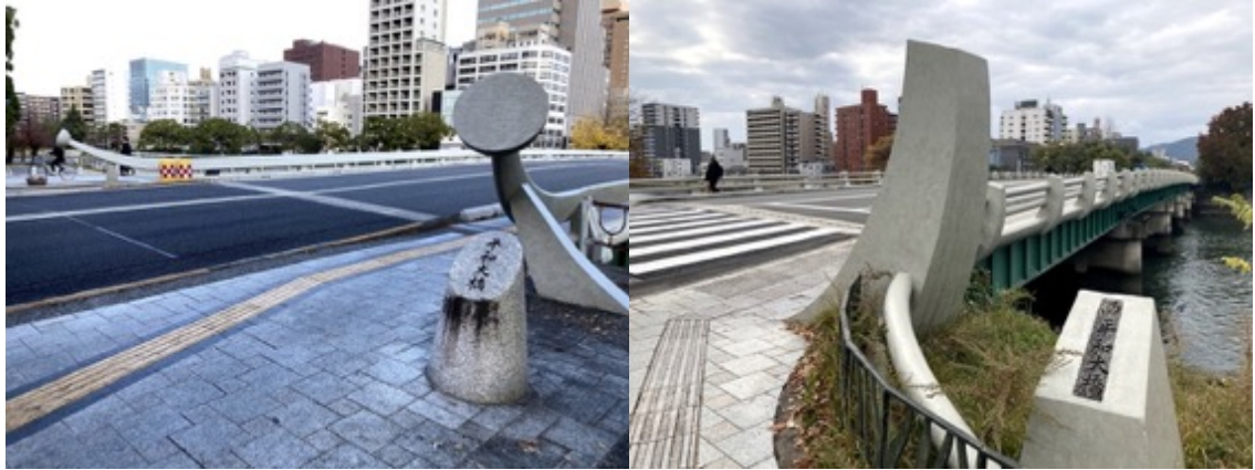
図 37 左が平和大橋、右が西平和大橋
