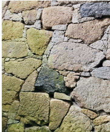
(71) 姫路城の竜山石の石垣
