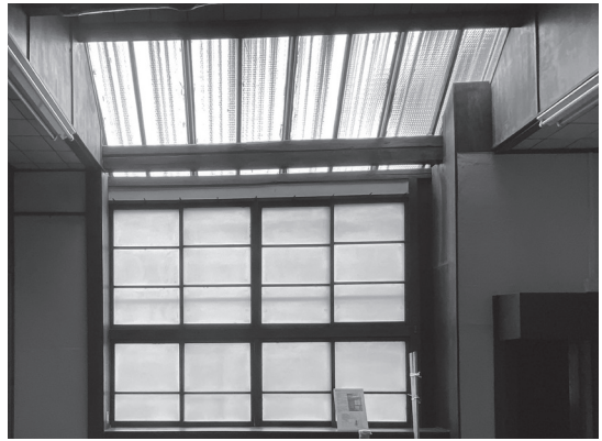
図5. 旧平櫛田中邸アトリエ内の窓
