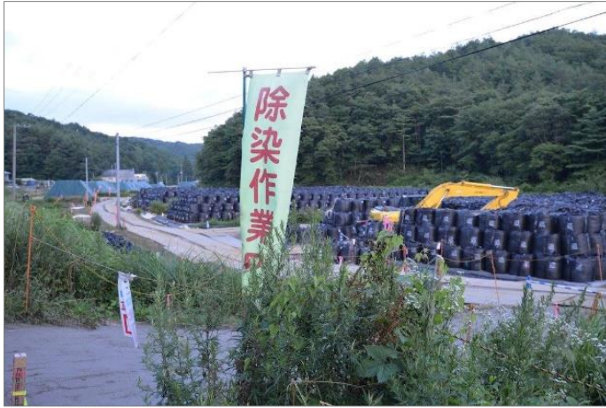
図9 2016年7月18日 飯舘村 除染作業中とフレコンバッグ
