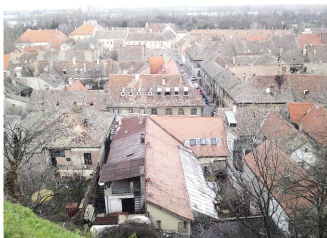
図7 崩れた屋根、錆びたトタン セルビア(筆者撮影) 風景全体から感じることは断片の総和を超えている。
