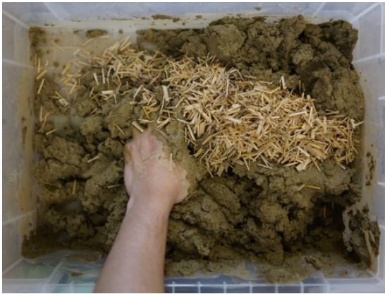
図 54 中塗り土に藁と粉殻を混ぜ込む
