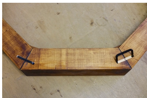
図19 鋸による補強
