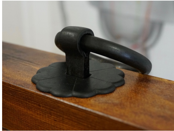
図 23 下穴を開け吊金具を打ち込む
