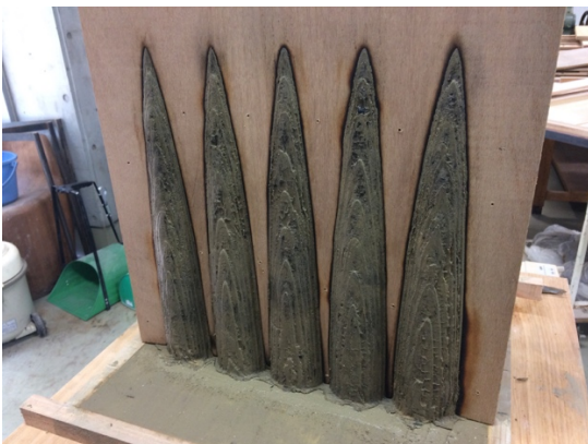
図 77 型を1枚ずつ剥がす
