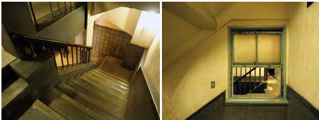
図36 奥野ビル内部
