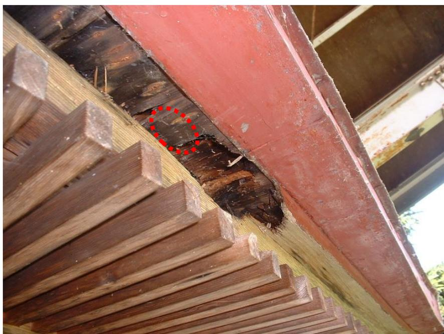
Fig. 5.25 木材サンプル収集部位（屋根野地板）
